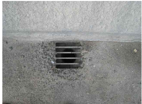
배수구 상태 양호
