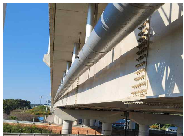
배수구 상태 양호 - 금회
