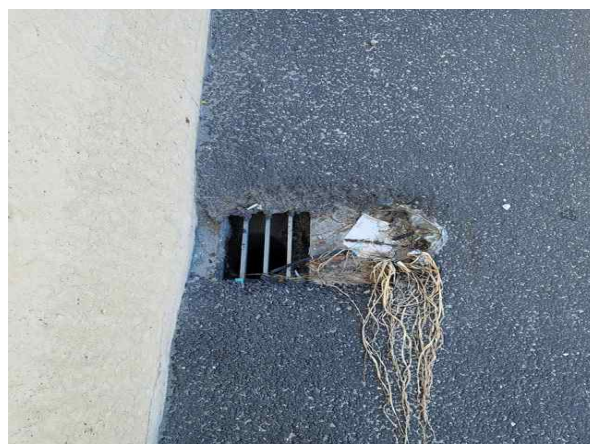
배수구 상태 양호
