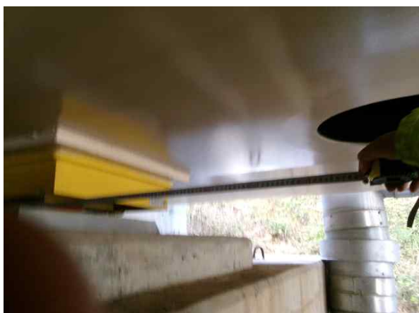
받침장치 연단거리 측정
