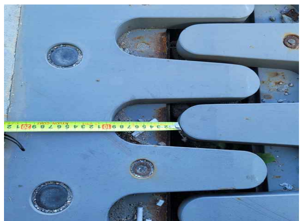
신축이음 이동량 측정
